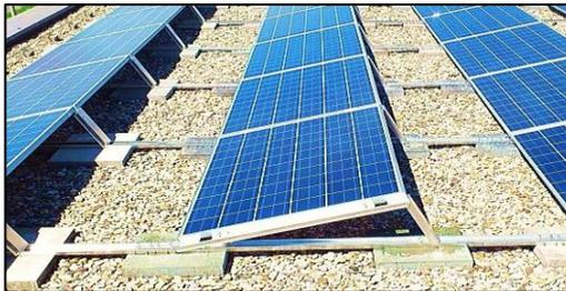
**Konstrukcija solarne elektrane na ravnom krovu (šine)**
