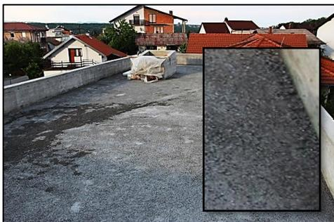
Zrnata struktura perlita kao prvi sloj izolacije krova (mješavina lakog betona i stiropora)
